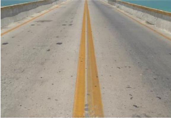
*Ilustración 8- Desgaste en Losa en claro*
