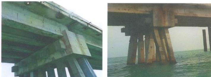
*Ilustración 17- Parte inferior de traveses en donde se aprecia que la trabe se colocó contra el suelo sin cimbra.*
