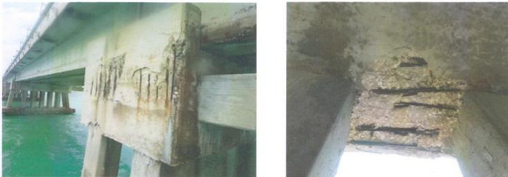
*Ilustración 16- Acero expuesto encara transversal de cabezal de pilas*
