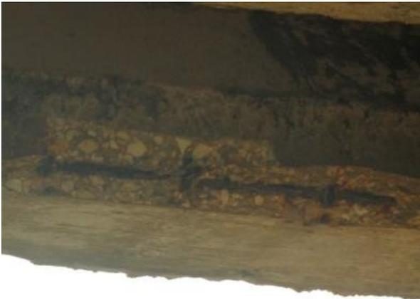
*Ilustración 10- Trabe sin concreto de revestimiento, exponiendo acero a la corrosión*
