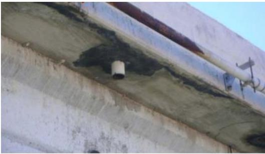
*Ilustración 12- Drenes; insuficientes en temporada de lluvias y sin mantenimiento*
