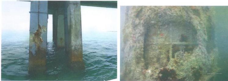
*Ilustración 15- Parte superior del pilote, presentando ruptura y parte sumergida de pilote*
