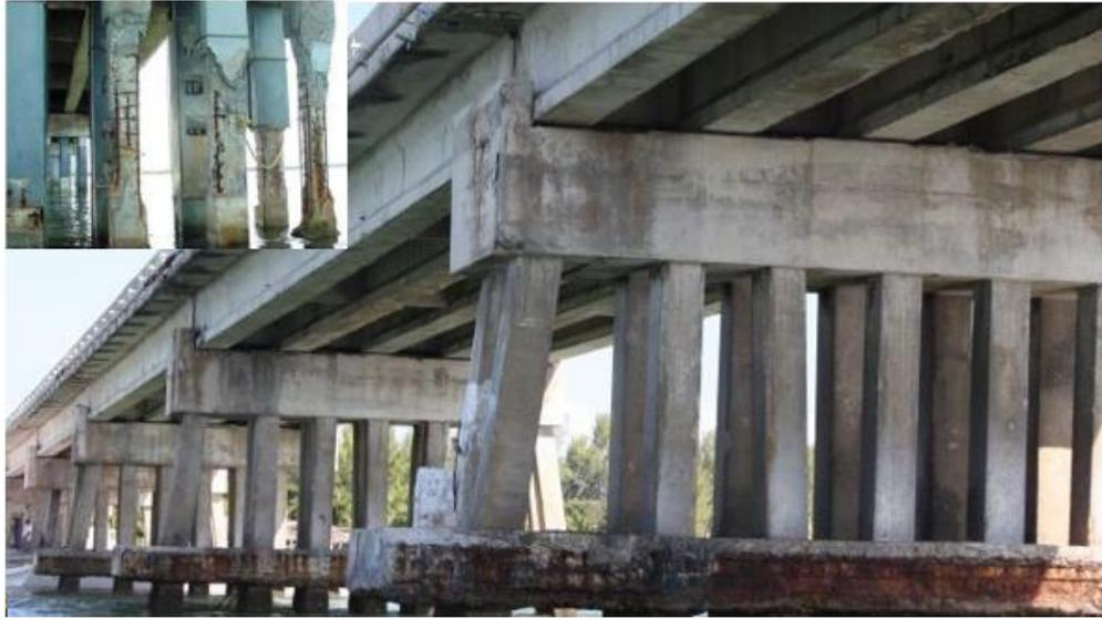
Ilustración 21- Subestructura y condiciones de deterioro
