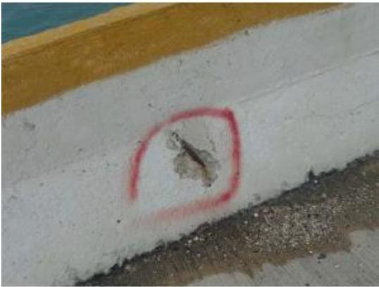
*Ilustración 9- Desconche con refuerzo expuesto en la guarnición hombro izquierdo, se aprecia encharcamiento y arena*
