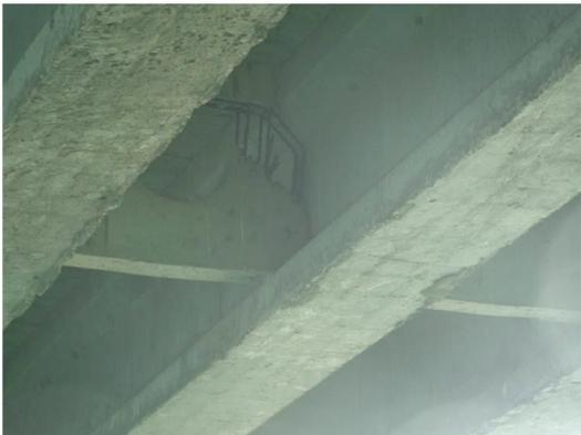
*Ilustración 13- Diafragma entre trabe con acero expuesto*
